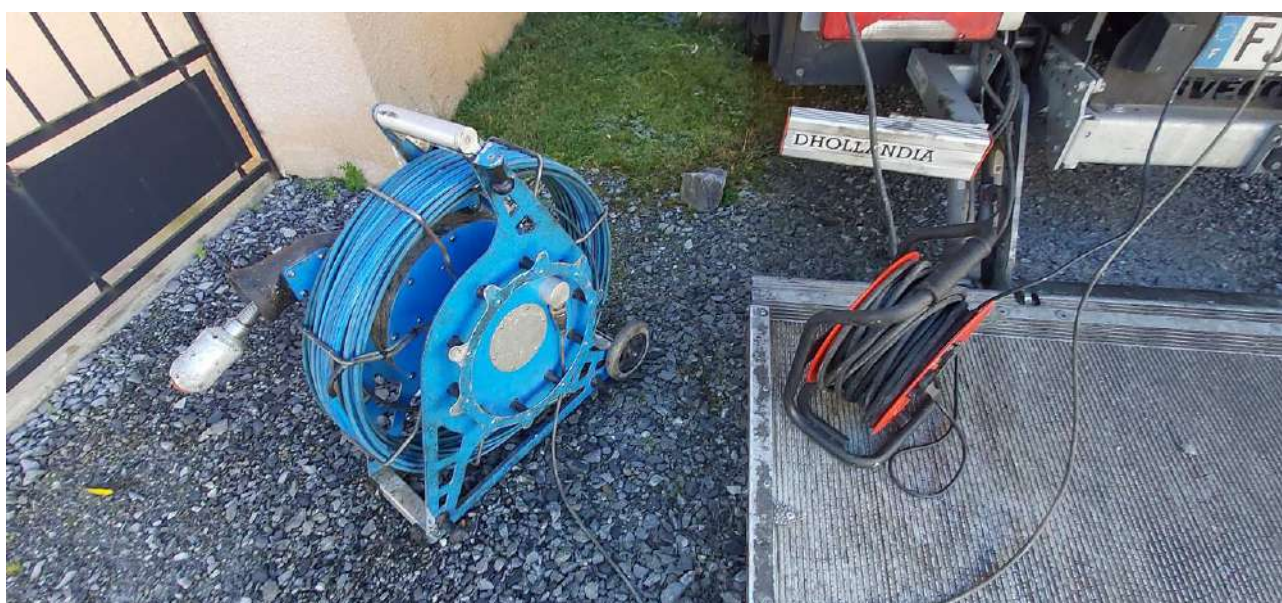
Passage de caméra dans les réseaux.
