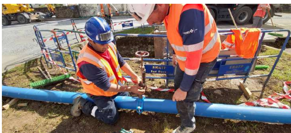
Mise en place d'un robinet de prise en charge pour un branchement d'eau sur une conduite principale
