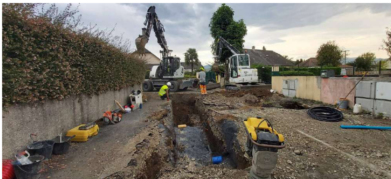
Travaux de pose des réseaux d'eau et d'assainissement à Lagos
