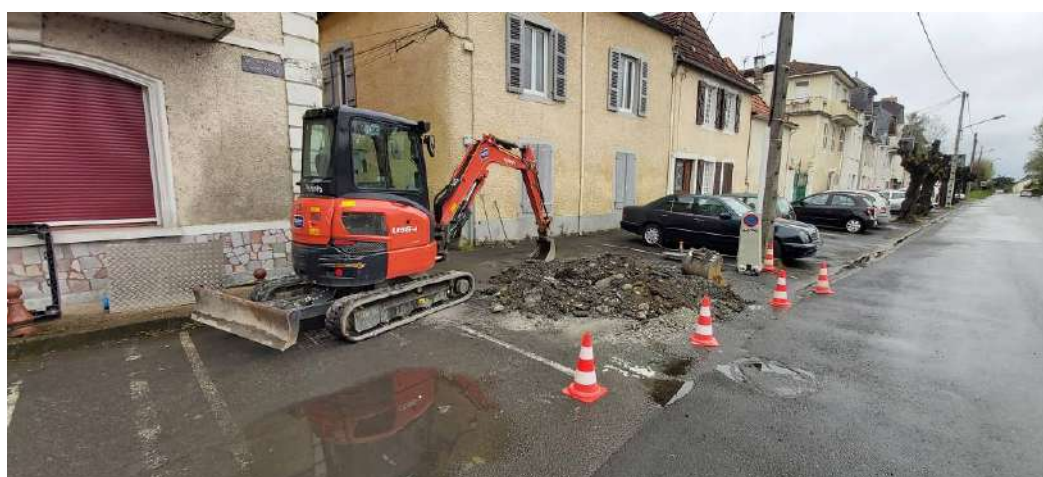
Réalisation d'un branchement d'eau à Nay.
