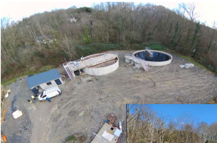
Travaux de réhabilitation de la STEP d'Asson 2 000 EH
